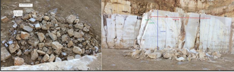
Şekil 6. Söküm yapılacak kütle (dilimin) önüne yapılan yastıklama malzemelerinin durumu
